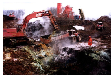
Photo 3 : Extraction (premier plan) et traitement (second plan) des résidus acides
