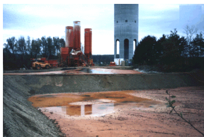
Photo 2 : Assèchement de la lagune après traitement des eaux
