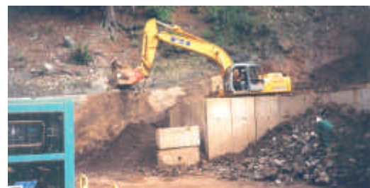
Atelier de séparation / criblage
