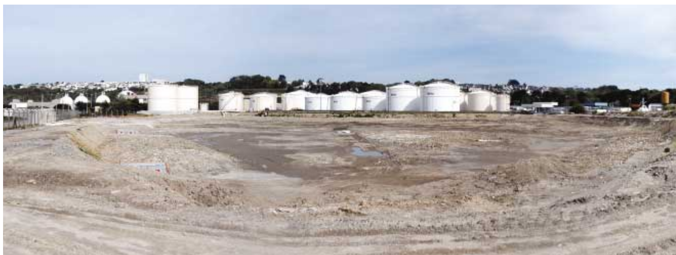
Vue générale du site après les travaux
