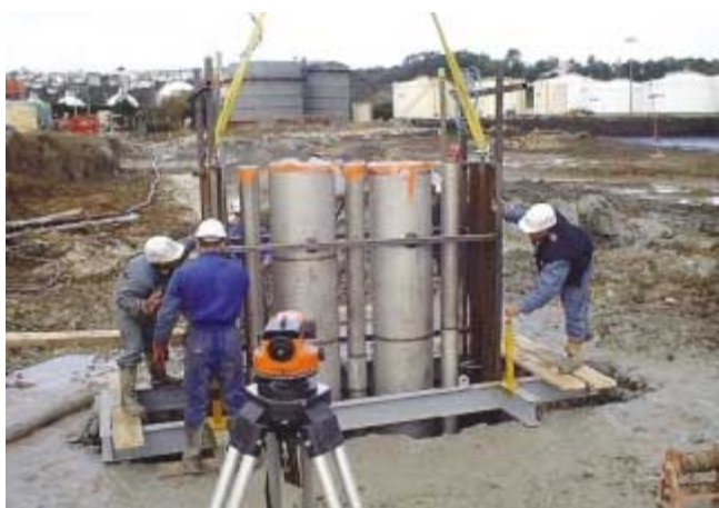
Mise en place de la porte filtrante
