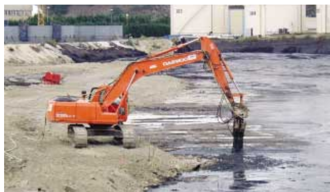
Vue du malaxeur in situ
