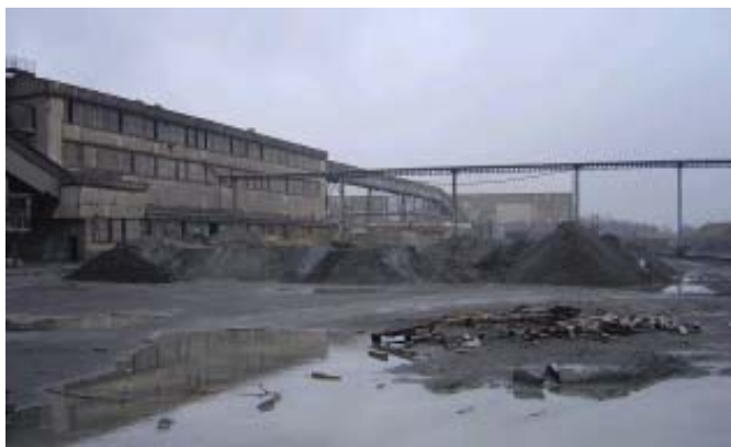
Vue initiale du site
